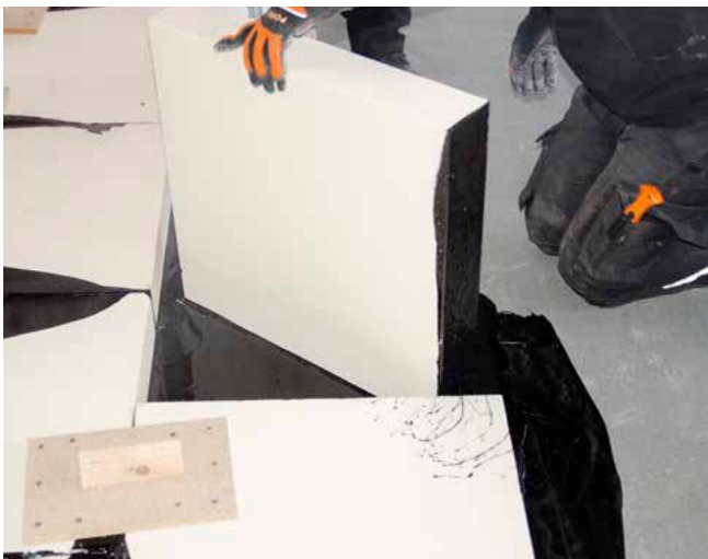
Wärmedämmung BauderPIR KOMPAKT eingießen
