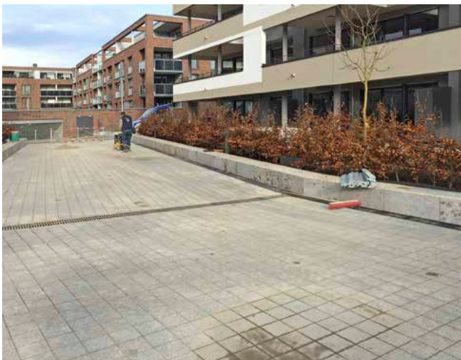
Betonpflaster auf Splittbett
