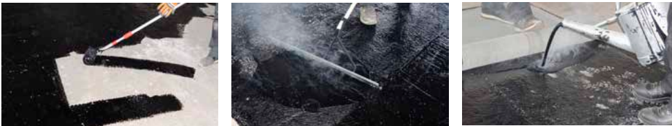
Veranschaulichung Aufbringen des Voranstriches und der Heißbitumenmasse.
