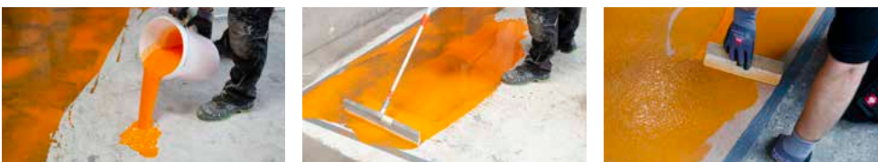
Veranschaulichung Aufbringen der PMMA-Versiegelung.
