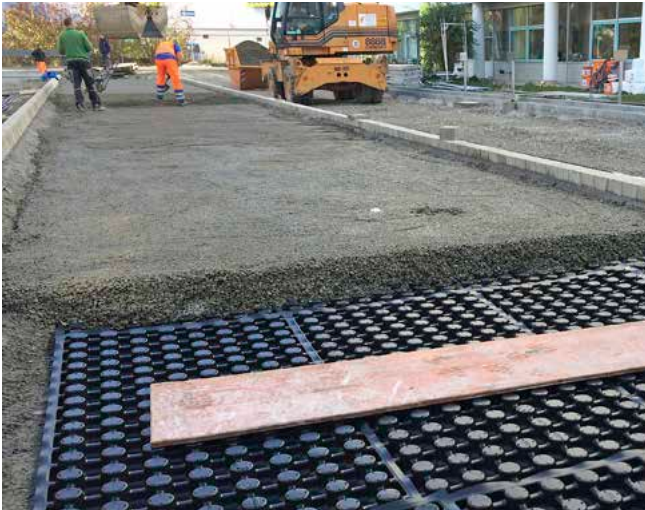
Tragschicht einbringen
