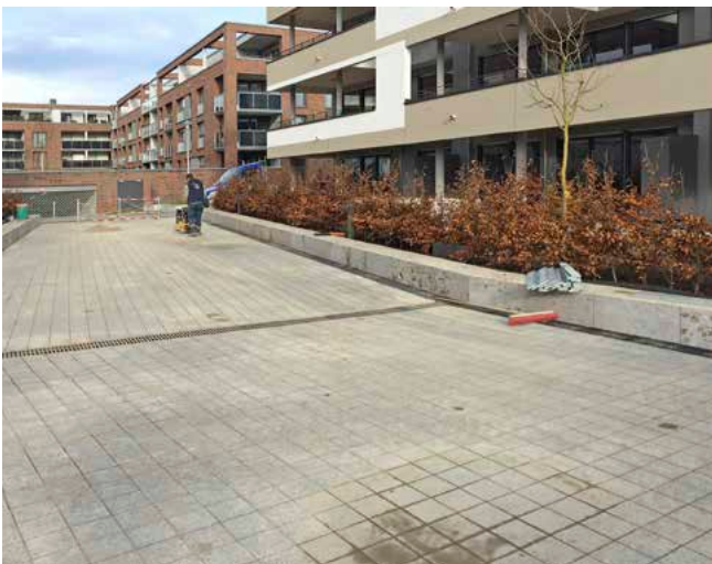
Betonpflaster auf Splittbett
