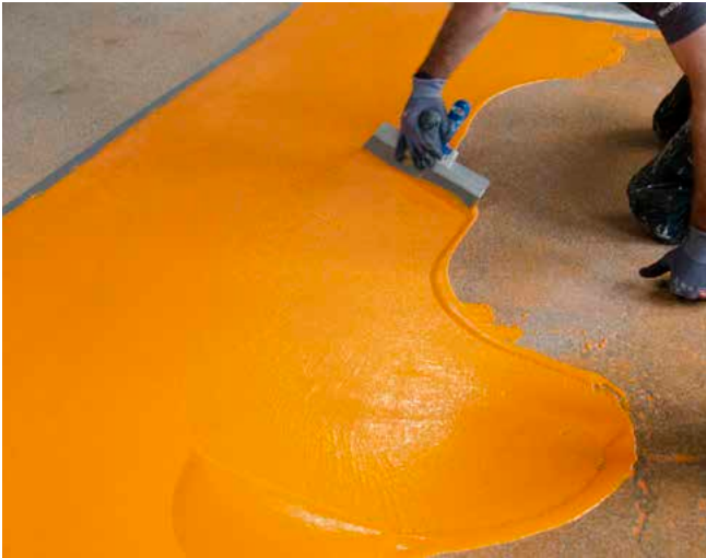
Reaktionsharz (PMMA) aufbringen
