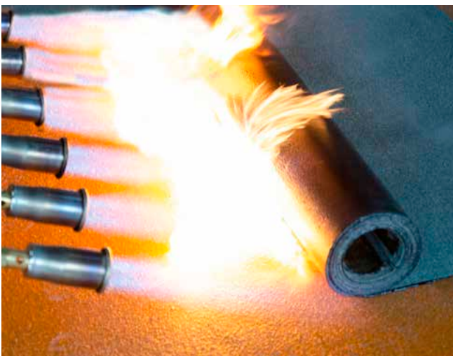
Dampfsperre BauderFLEX DNA aufschweißen
