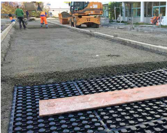
Tragschicht einbringen
