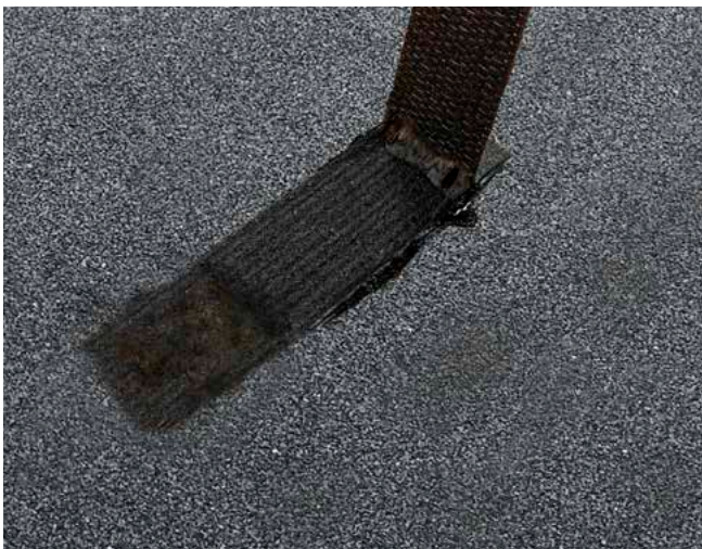
Eine Haftzugprüfung in Form eines Abreißversuchdurchgeführt
