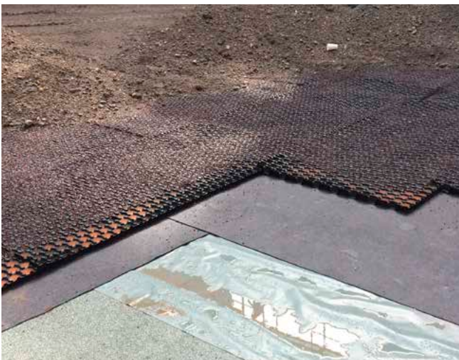
BauderGREEN PE 02 und BauderGREEN FSM 600 aufbringen
