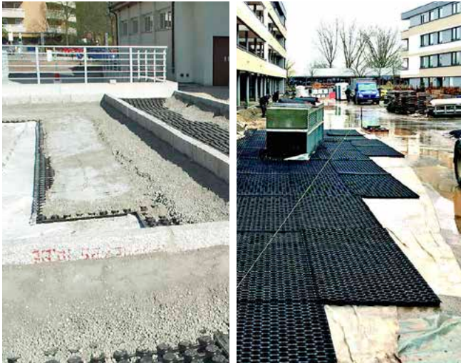
BauderGREEN DSE 40 verlegen
