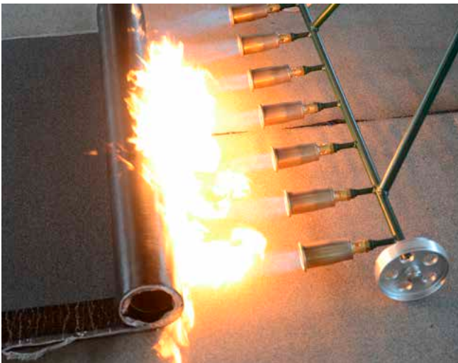
Oberlage BauderKARAT/BauderSMARAGD aufschweißen
