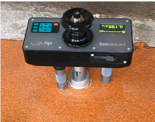
Oberflächenfestigkeit und Haftverbund prüfen
