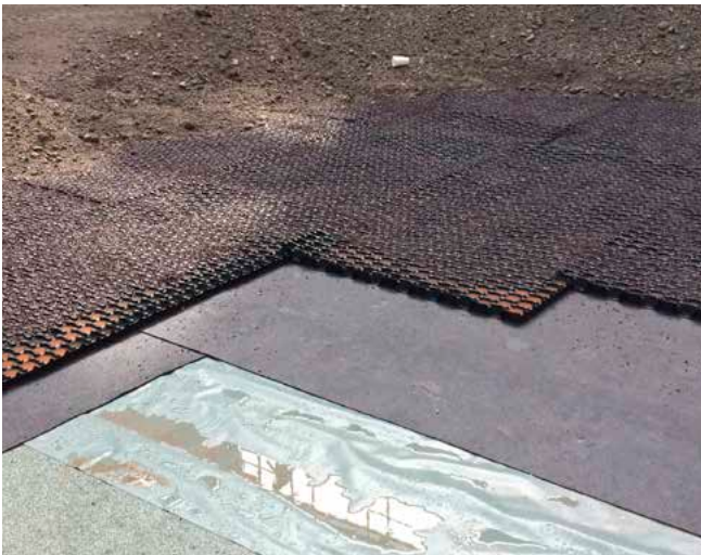
BauderGREEN PE 02 und BauderGREEN FSM 600 aufbringen
