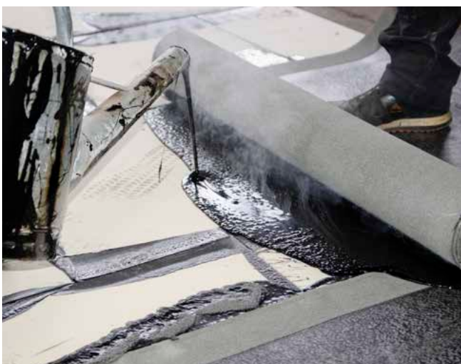
Erste Abdichtungslage BauderKOMPAKT ULK eingießen
