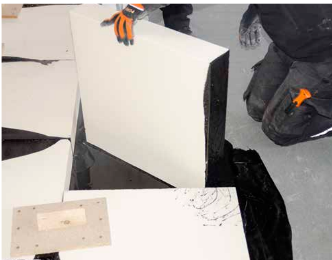
Wärmedämmung BauderPIR KOMPAKT eingießen
