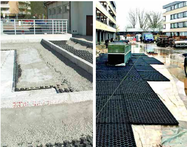
BauderGREEN DSE 40 verlegen
