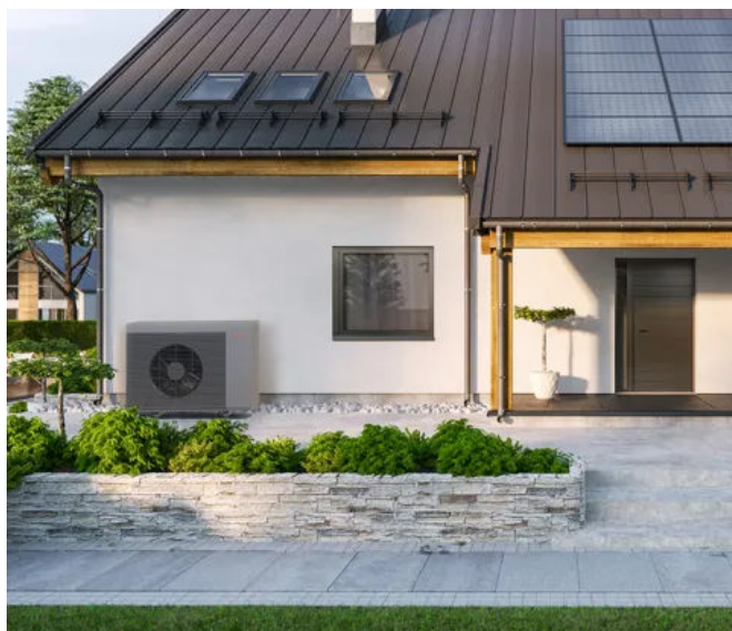
e Installation der Wärmepumpe in einem Vorgarten ist eine übliche Aufstellvariante. Geringe Abstände zur Hauswand erhöhen den Schallpegel. (© Wirestock Creators/Shutterstock)
