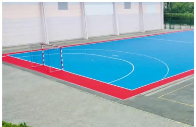
Ein neuer Sportboden ist schnell verlegt: Ein Spielfeld mit einer Größe von 1000m<sup>2</sup> ist von 4 Personen einschließlich Markierung in ca. 6 Stunden verlegt.
